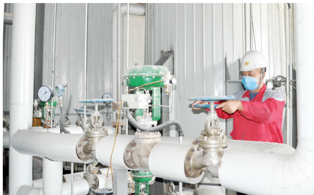
9月13日,肇东市隆信锐意公司的工人正在生产线查看压力表,确保生产出高品质蒸汽玉米压片。 公司拥有电脑控制全自动化蒸汽压片玉米生产线三条,年加工玉米能力可达21万吨以上,产品远销内蒙古、河北、山东、四川、陕西等地。 特约记者 霍永祥摄
